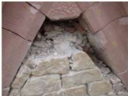
Loses Mauerwerk unter Turmgiebeln
